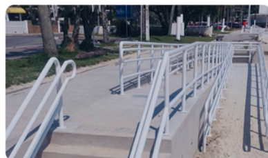
GUARDA CORPO EM AÇO GALVANIZADO
